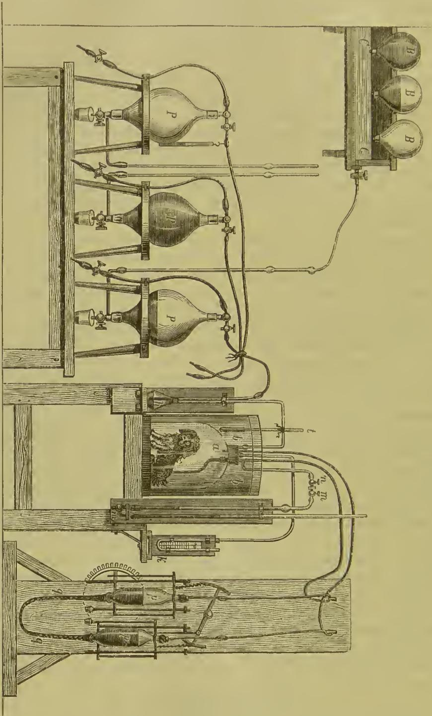
zu aus einem Bassin mit Chlorcalciumlösung (*C C*), in welchem ein näherungsweise constantes Niveau dadurch hergestellt ist, dass mehrere Ballons, welche mit Chlorcalciumlösung gefüllt sind, umgestürzt sind, so dass sie mit ihren unteren Enden in die Chlorcalciumlösung hineinragen.
